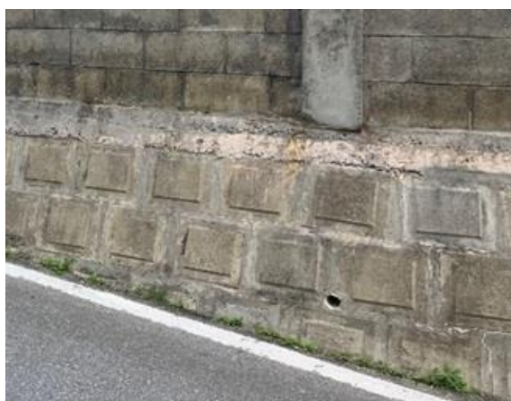
間知ブロックの擁壁
