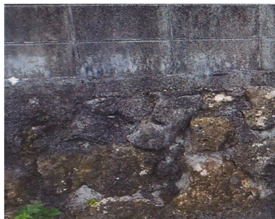
自然石積みの擁壁
