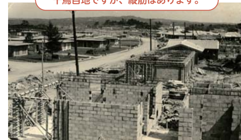
1951年当時の嘉手納基地内住宅工事の様子 沖縄市提供
