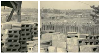
1951年当時の嘉手納基地内住宅工事の様子 沖縄市提供
