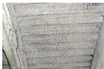
吹付け材の例(床・天井)
