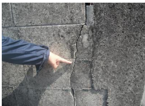
ひび割れなどの目視、外観調査
